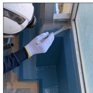
(左) 補強メッシュ張り [バルコニー最上階底] (右) ウレタン1層目 (下) トップコート塗布 [手摺立上り・排水溝]
