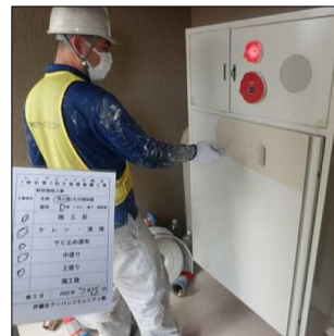
(左) サビ止め塗布 * 白っぽい部分 (右) 中塗り (下) 上塗り * 中段濃い色部分
