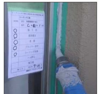
(左) 既存シールの撤去 (右) シール充填 (下) ヘラ押え後・塗装前
