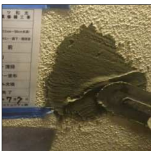
(左) 施工前 (右) 鉄筋 はっ 筋り出し 錆落とし後 (下) モルタル充填
