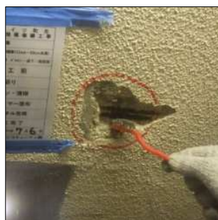
(左) 施工前 (右) 鉄筋 はっ 筋り出し 錆落とし後 (下) モルタル充填
