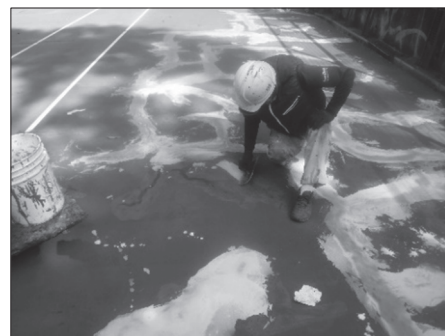
クラック補修
