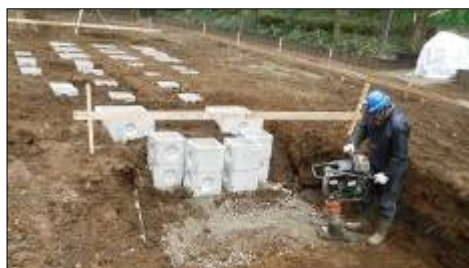
遊具基礎設置
